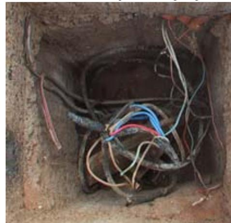
suspectant d'être raccordé en 380. Mauvaise nuit, on aura peu dormi. Le lendemain vérification : 360 V mesurés ! Un "Estérel" voisin a eu son chargeur grillé. Quand on voit comment l'installation électrique est bidouillée on comprend tout. Ce regard couvert d'une dalle a été pris pour un égout, des eaux usées y ont été déversées à commencer par les miennes. En fait c'est une boîte de dérivation électrique comme n'en voit pas chez nous... Étonnez vous du résultat !
